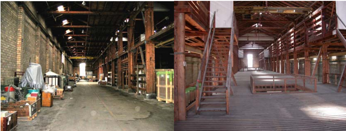
Halle 710, Zustand 2010: Halle allgemein und Galerie
